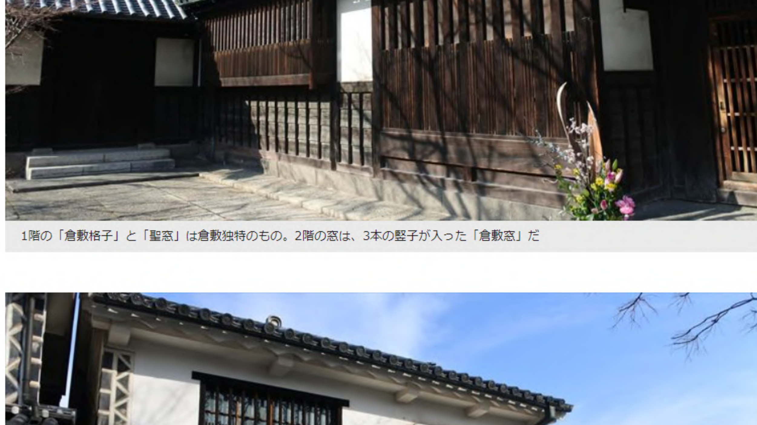
2階の白い窓は、窓格子が透り込めになった「虫籠窓（むしごもだ）」で、主屋正面2階に設けられる。左側の窓は倉敷格子
